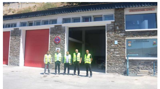
El diputado de Asistencia a Municipios visita las obras del parque de Sierra Nevada.
